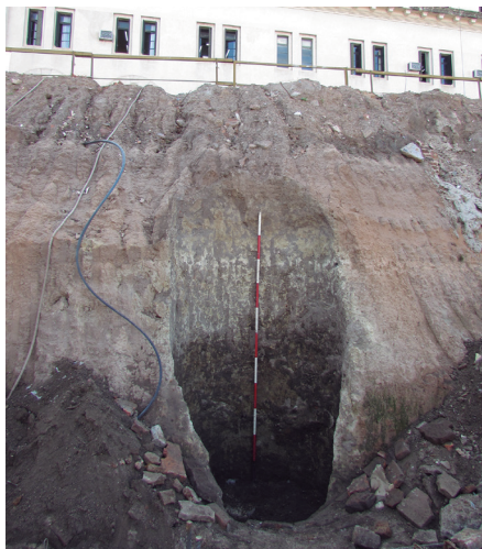
Figura 7. Perfil del pozo de basura en el talud de la obra. Detrás se observa el edificio de tribunales.
