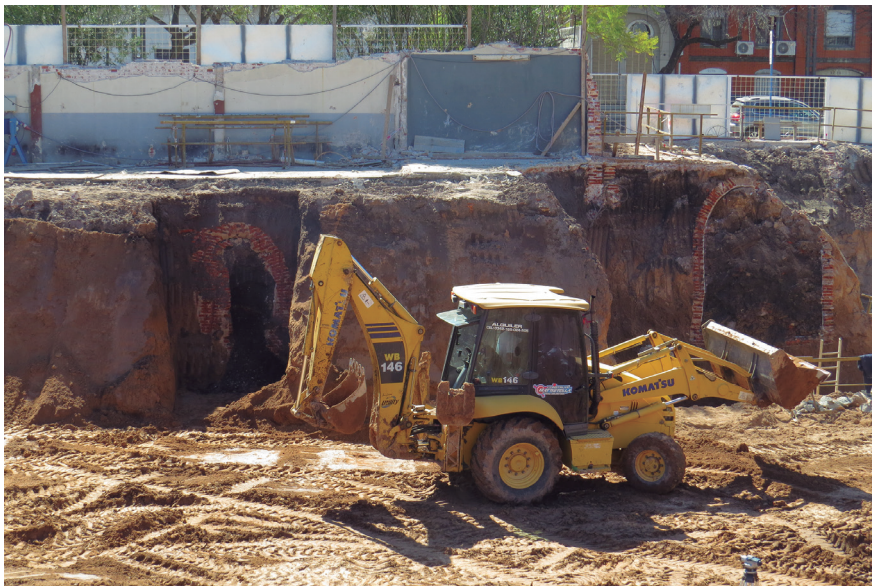
Figura 5. Perfil donde se observan dos de las cisternas seccionadas durante la obra.
